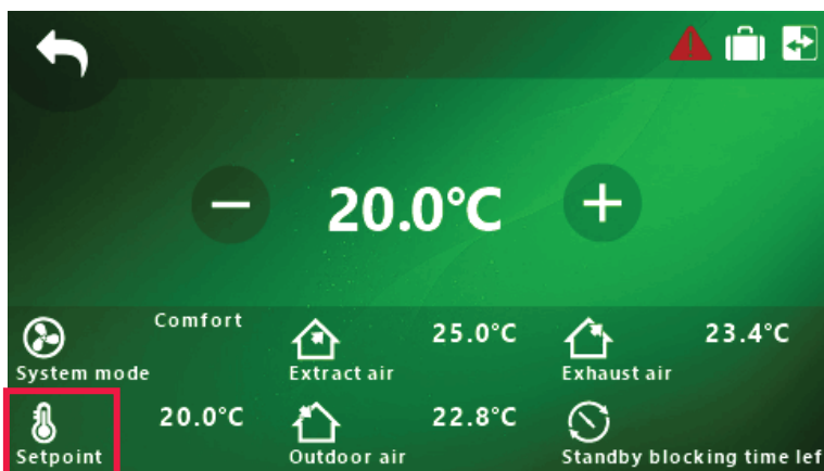
Fig. 5.6.1.4 Skärmbild av temperaturbörvärde i ST-SA-Control och SALDA AIR
